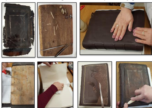
Fig. 6. Emolieria învelitorii vechi, consolidarea scoarțelor îmbrăcarea volumului cu piele nouă, fixarea ligamentelor, fixarea forțașurilor fixe și mobile, pregătirea și fixarea intarsiei.
