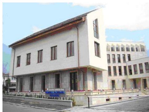
Fig. 3. Sediul Laboratorului de Restaurare-Conservare al Muzeului Olteniei Craiova.
