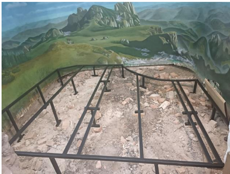
Fig. 4. Reconstruirea suportului platformei.
