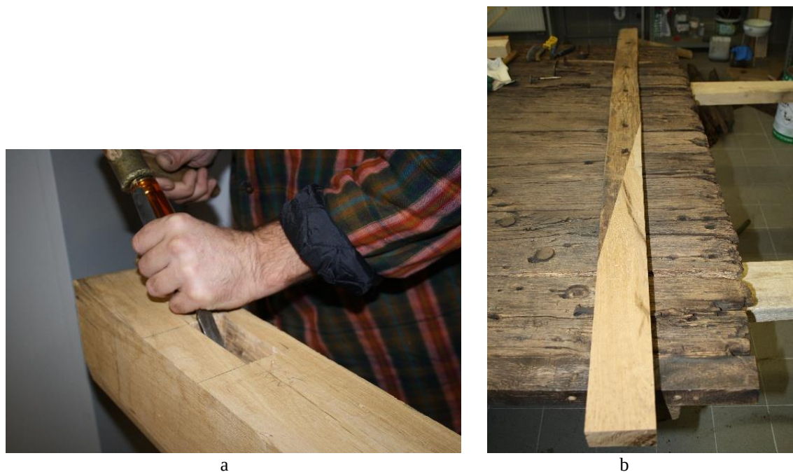
Fig. 5. Completări ale elementelor structurale de lemn.
