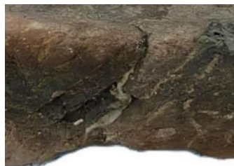
Fig. 6. Spații interstițiale: a - pierderi de material la îmbinările fragmentelor; b - fisura.
